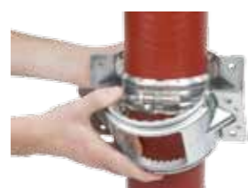
将加强型卡箍的两个部件对称套在接口处。
