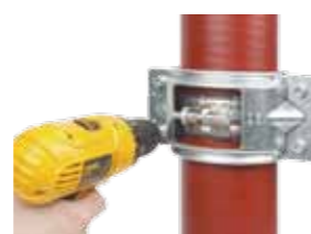
之后再交替拧紧螺栓,确保两侧耳板间隙相同。
